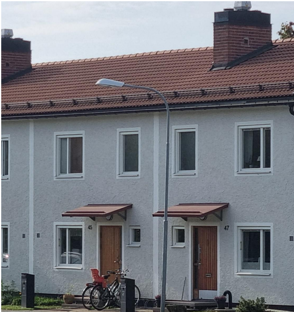
Gråa byggnadernas entréside
