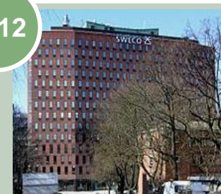
AMF, SWECO-huset • 28 borrhål
